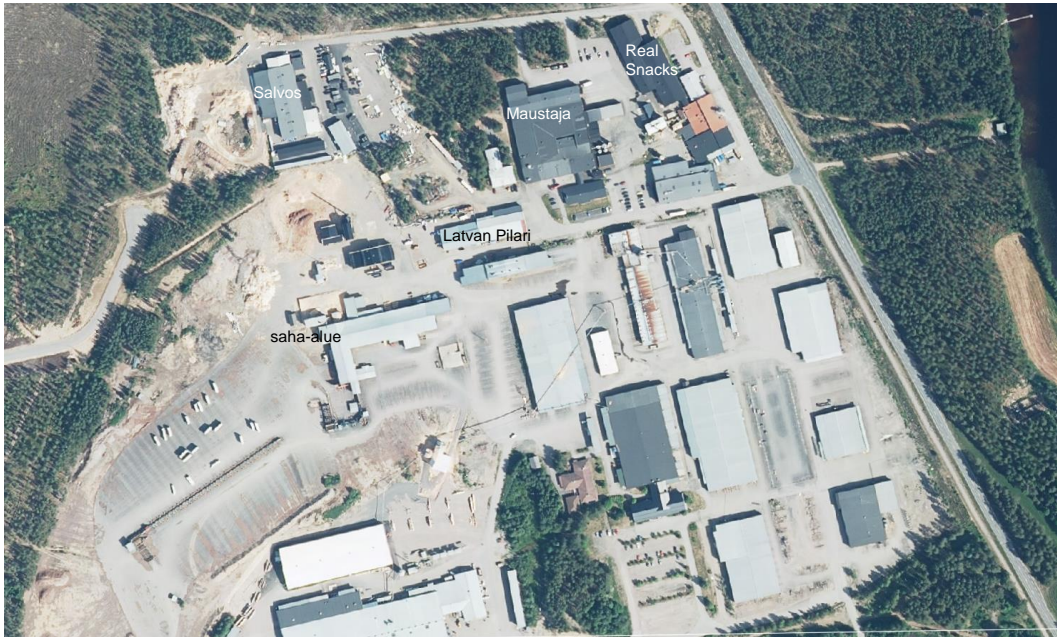
Ilmakuva 2018. Leiviskänkänkaan länsiosan laajennusalueelle on toteutettu uusia teitä. Sahan toiminta keskeytyksissä, sen kuivaamo on muutamaa vuotta aikaisemmin uusittu ja Real Snacksin tiloja on laajennettu. Jukkatalolle (sahan eteläpuolella) on rakennettu laajennus.
